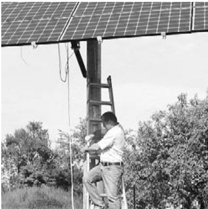
Verantwortlich für die Bauausführung zeichnete das Büro Feigl WeizSolar.
