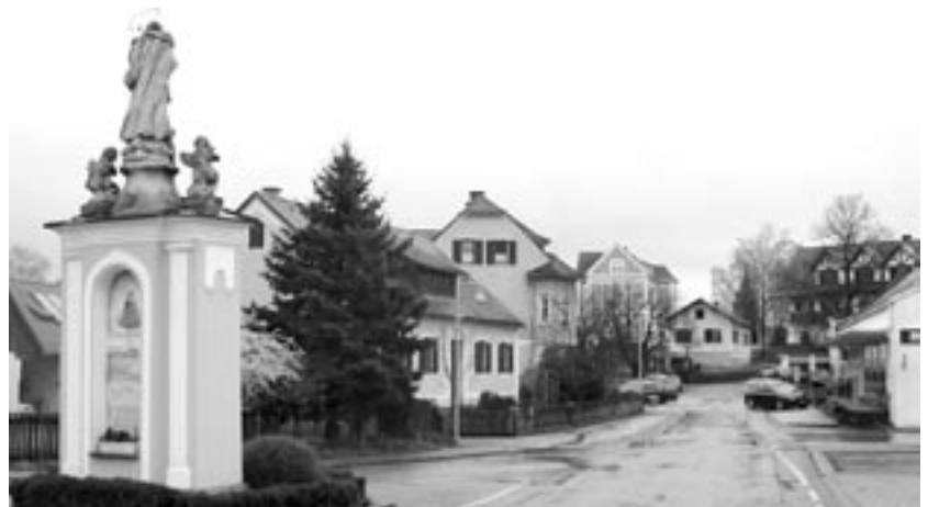
Teilweise brutale Fahrbahnschäden haben schon zu gefährlichen Situationen geführt.
