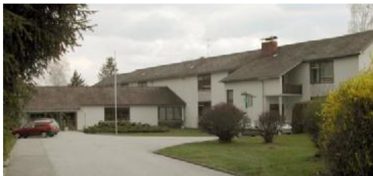
Energiepolitisch OK: Die Volksschule Söchau, beheizt mit Biomasse, stromversorgt mit Naturstrom
